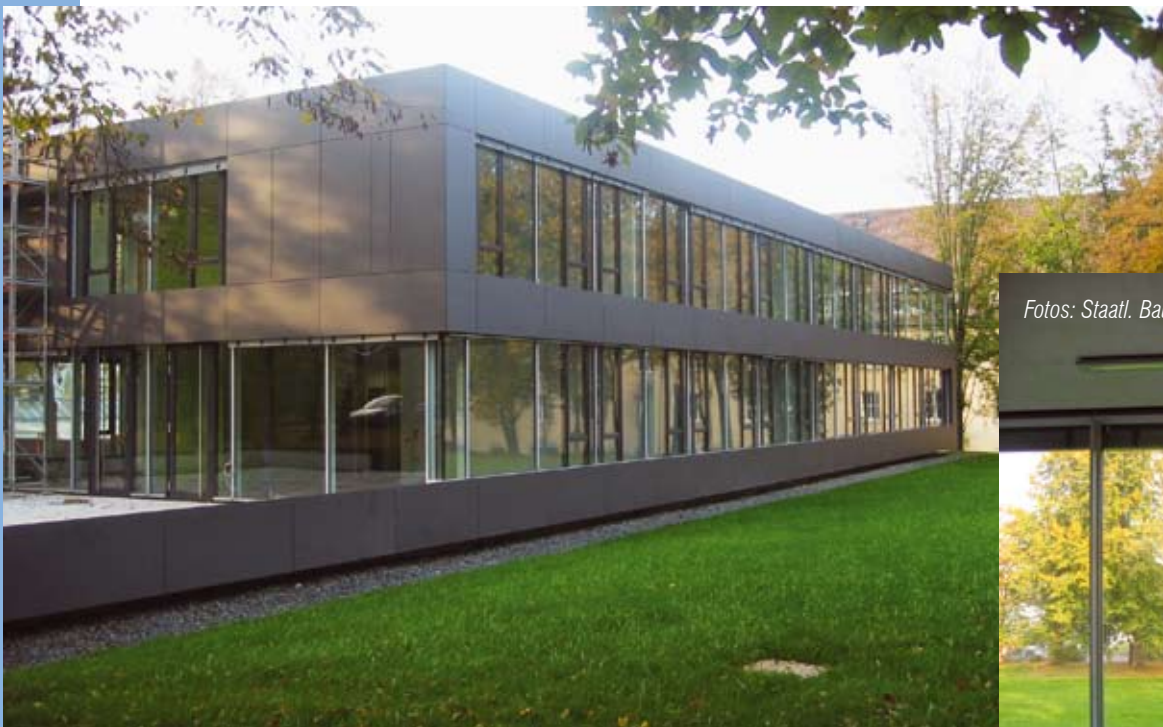
Nordost- Ansicht mit Blick auf den Altbau
